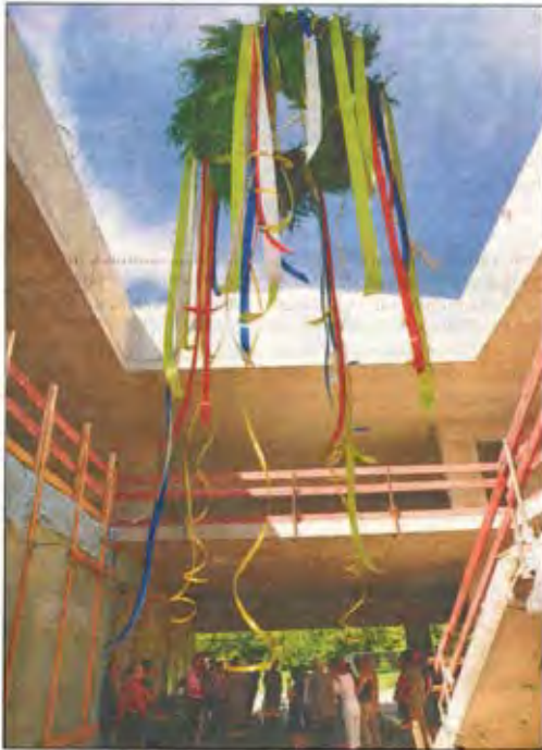
Der Kranz hängt , denn der Rohbau steht: Der 3,8 Millionen Euro teure Erweiterungsbau für die Martin-Buber-Schule soll in den Osterferien 2012 von Fünft- und Sechstklässlern der Gesamtschule bezogen werden. Am Mittwoch war erst einmal Richtfest. FOTO: DAGMAR MENDEL
