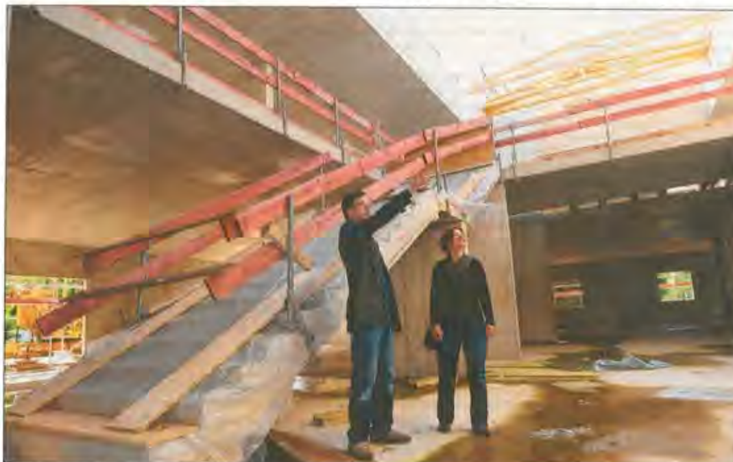
Der Rohbau steht: Marko Jäger vom Architekturbüro und Projektleiterin Michaela Eich erklären, wo welche Räume im Neubau der Martin-Buber-Schule sein werden. Die beiden sahen sich am Donnerstag in der Eingangshalle des Gebäudes um. FOTO: DAGMAR MENDEL
